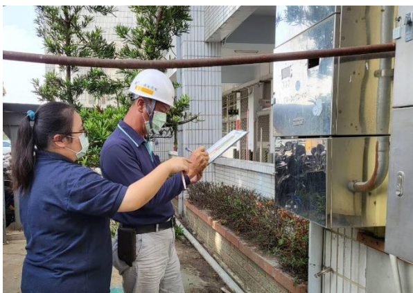
請專業的水電師傅到校檢查電路
